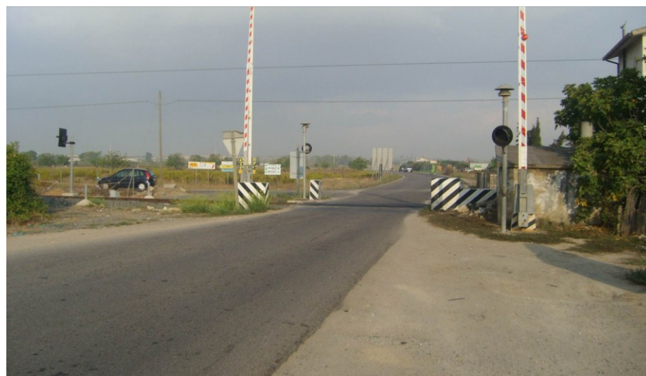
Foto 3 – Passaggio a Livello su Via Nenni
