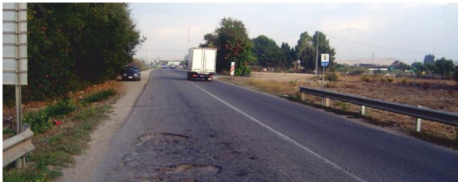
Foto 29 – Via Nenni nord – stato attuale
