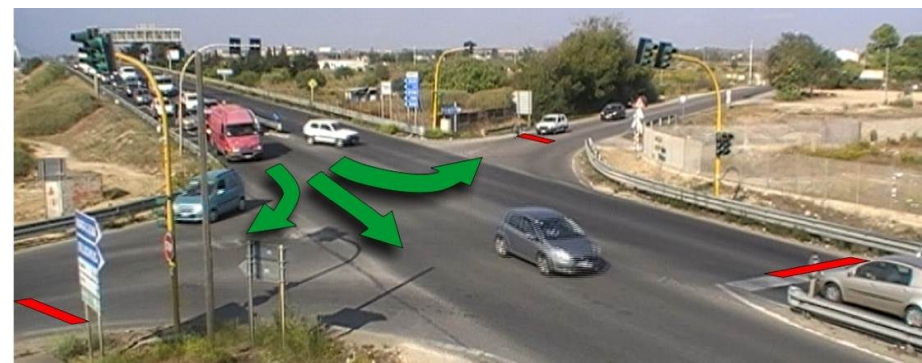
Figura 4 – Intersezione SS554 / Via Pietro Nenni – Ciclo semaforico – fase 1
